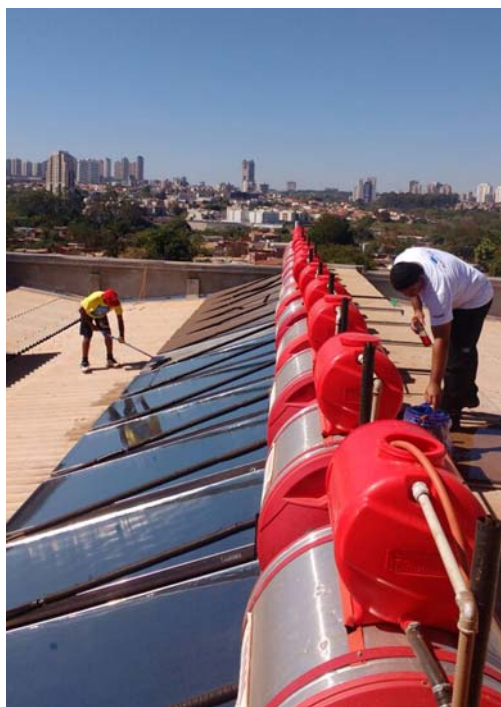
Limpeza e manutenção de painéis de energia solar em condomínio de Ribeirão Preto atendido pela JHE
